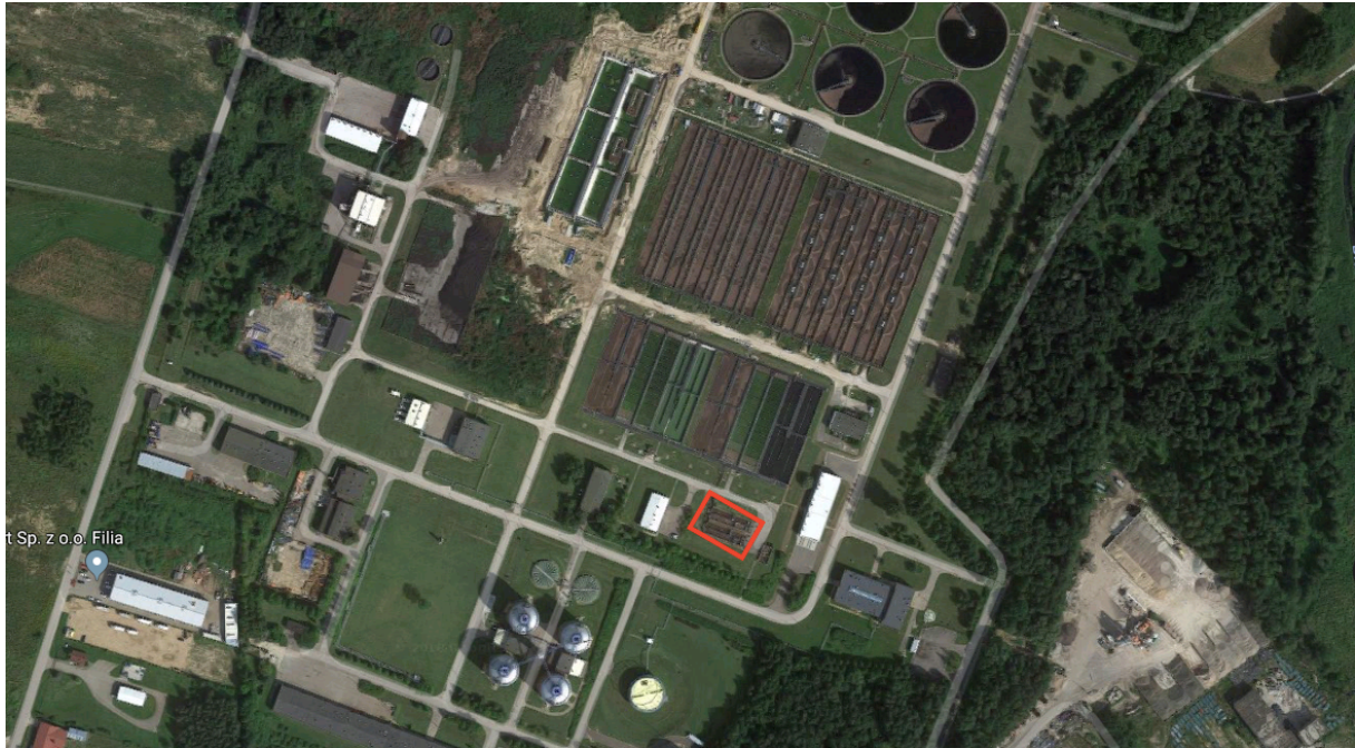
Rys. 6. Piaskownik z kanałem odpływowym ujęty ekspertyzą
