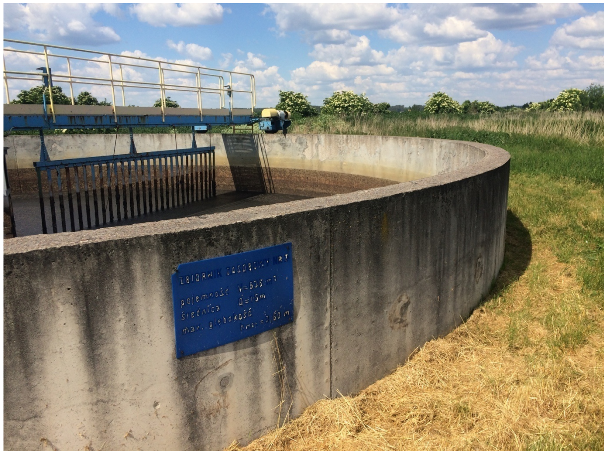
Rys. 13. Widok na zbiornik zasobowy
