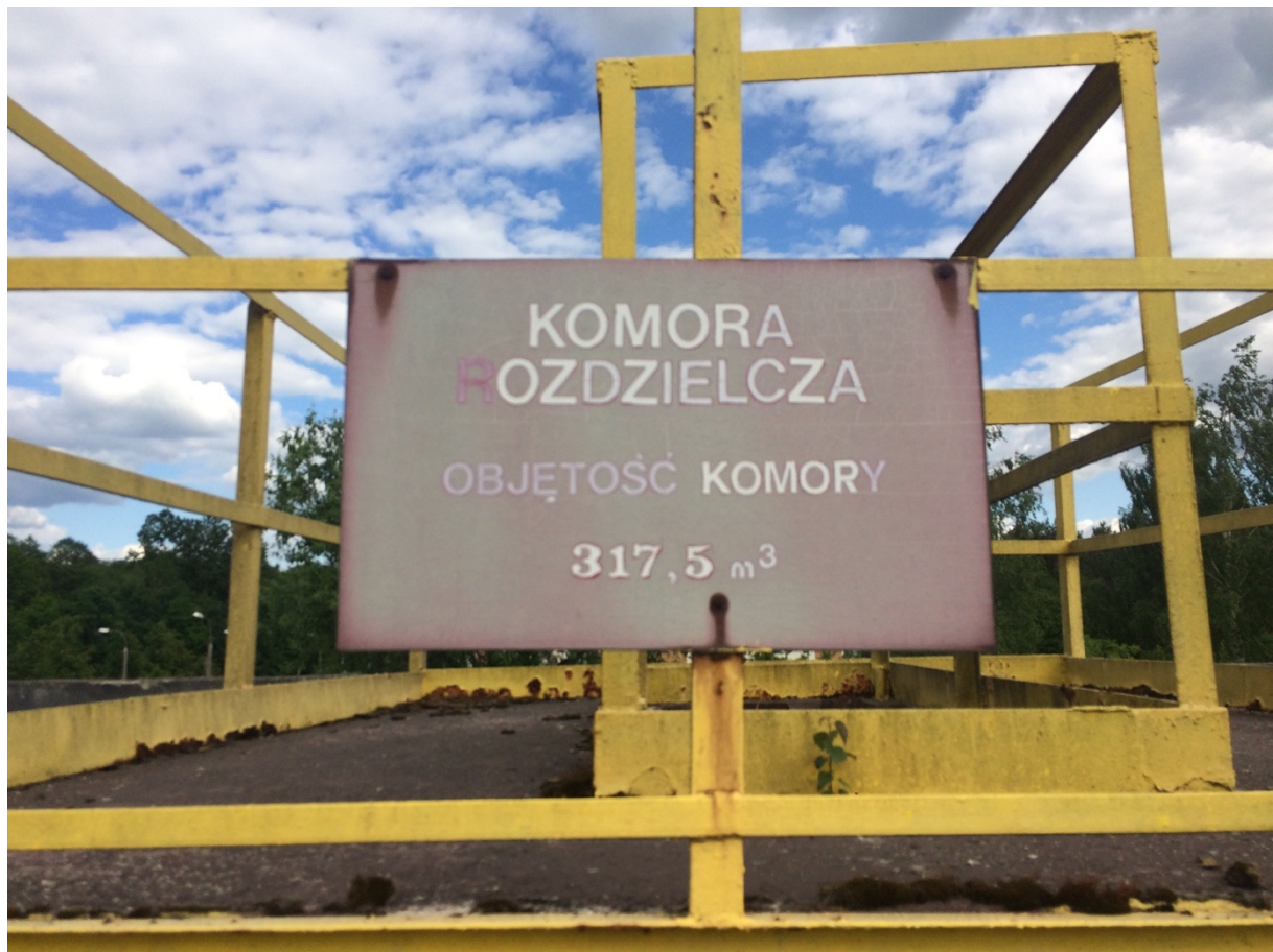
Rys. 5. Widok na komorę rozdzielczą
