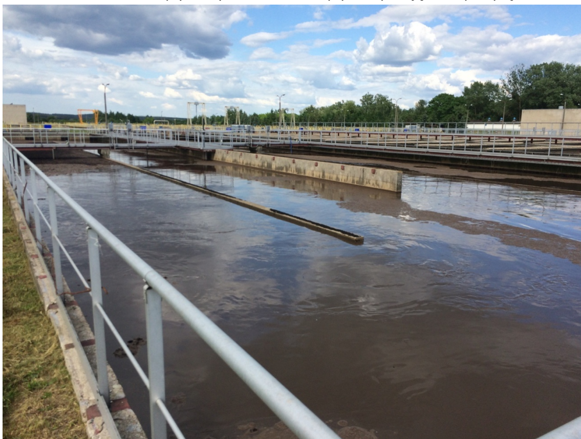
Rys. 9. Widok na osadniki wstępne oraz komory prenityfikacji i komory defosfatacji z kanałem dopływowym i kanałem odpływowym
