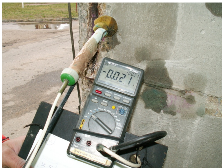
Rys. 12. Pomiar potencjału korozyjnego
