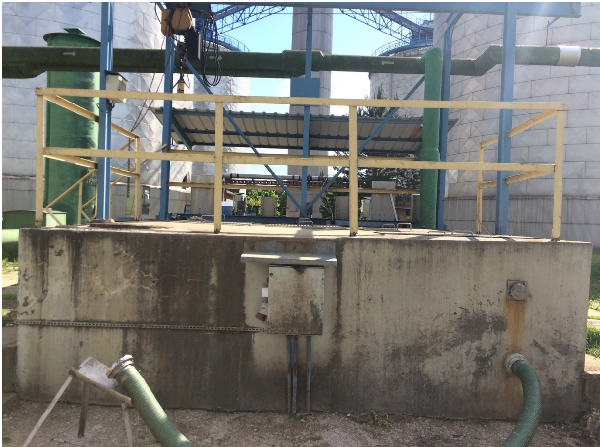
Rys. 17. Widok pompowni II o
