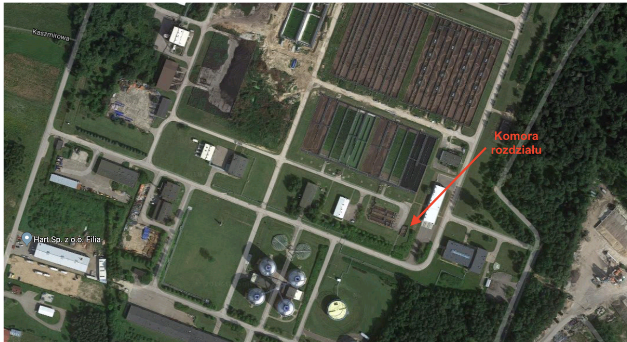
Rys. 4. Komora rozdzielcza ujęta ekspertyzą
