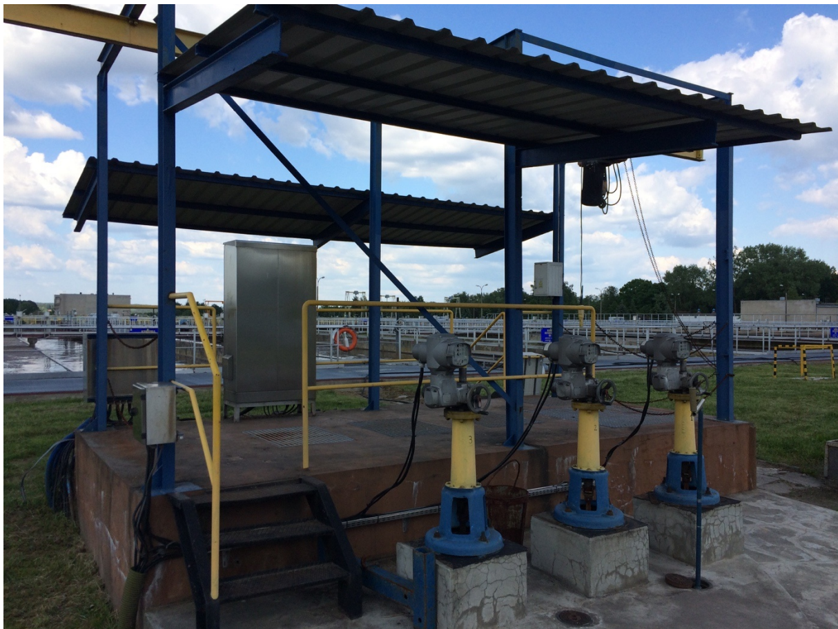
Rys. 11. Widok na pompownię I o
