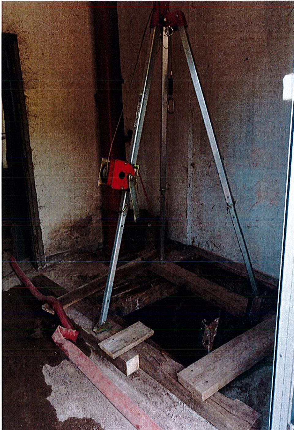
Rys. 3. Komora nr 2 przygotowanie do inspekcji
