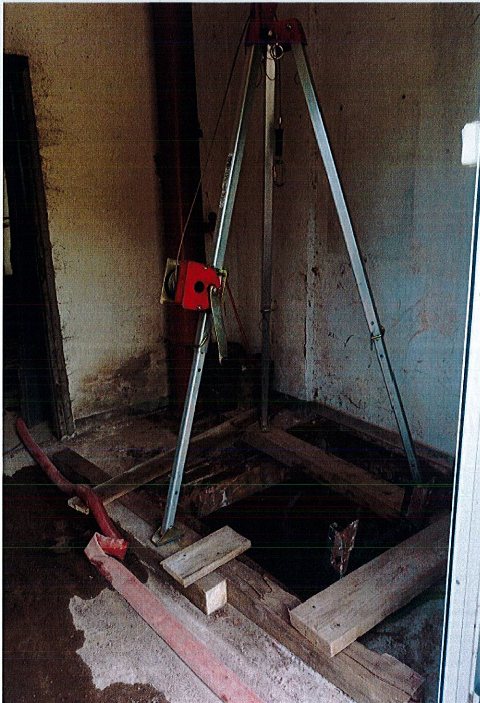
Rys. 3. Komora nr 2 przygotowanie do inspekcji
