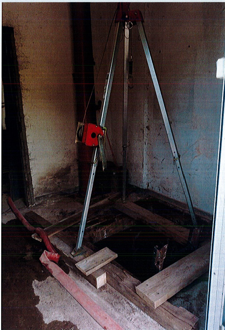
Rys. 3. Komora nr 2 przygotowanie do inspekcji
