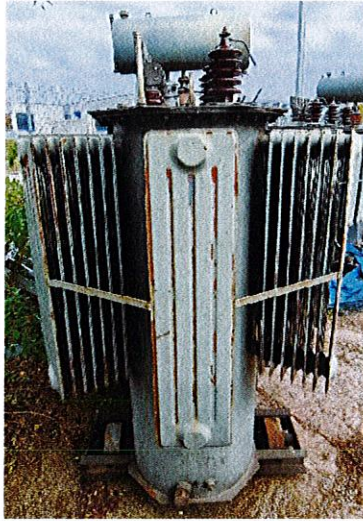
5) Transformator olejowy:TA0a-630/15,75, o mocy: 630 kVA, rok produkcji:1970, nr fabr.:117739,
