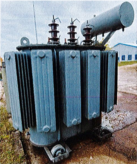
5) Transformator olejowy:TA0a-630/15,75, o mocy: 630 kVA, rok produkcji:1970, nr fabr.:117739,
