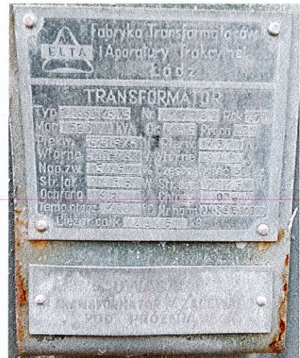
5) Transformator olejowy:TA0a-630/15,75, o mocy: 630 kVA, rok produkcji:1970, nr fabr.:117739,
