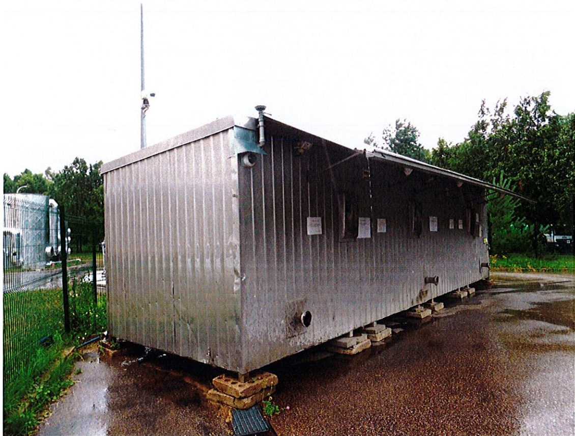
1. Kontenerowa stacja zlewna nieczystości ciekłych, rok budowy 2012
