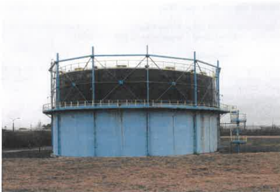
Istniejący zbiornik biogazu
