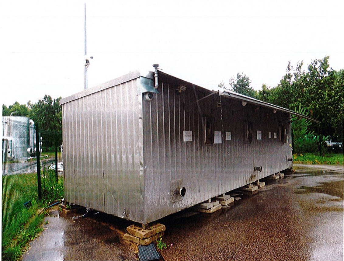
1. Kontenerowa stacja zlewna nieczystości ciekłych, rok budowy 2012
