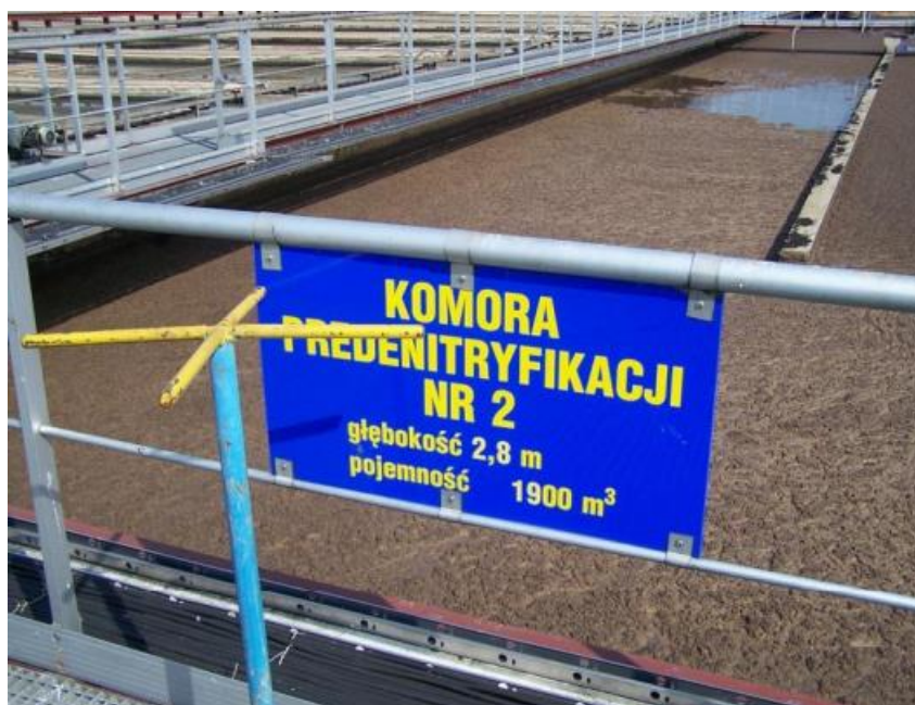
Rys. 7 Komora predenitryfikacji OŚ w Białymstoku (źródło: Wodociągi Białostockie)
