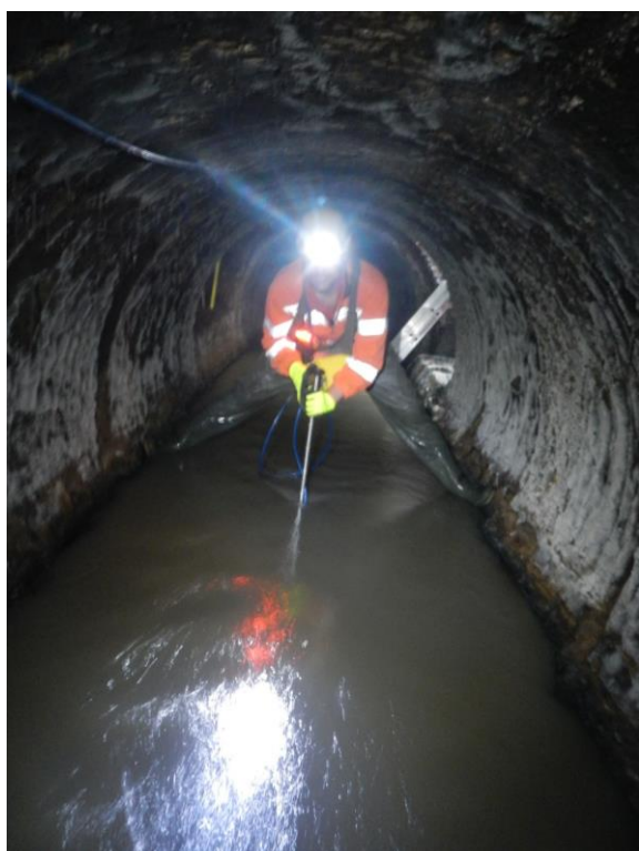
Rys. 15 Kalibracja urządzenia pomiarowego, zamontowany przepływomierz w punkcie nr 7
