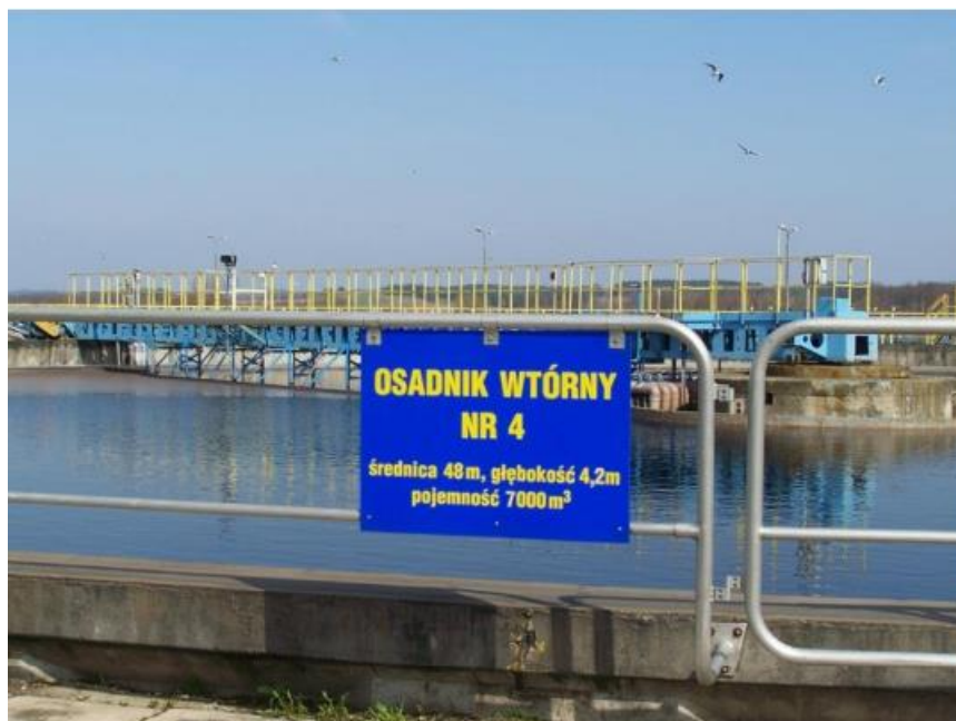
Rys. 9 Osadnik wtórny OŚ w Białymstoku (źródło: Wodociągi Białostockie)
