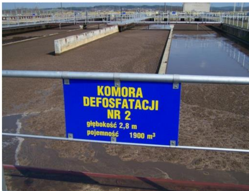
Rys. 8 Komora defosfatacji OŚ w Białymstoku (źródło: Wodociągi Białostockie)
